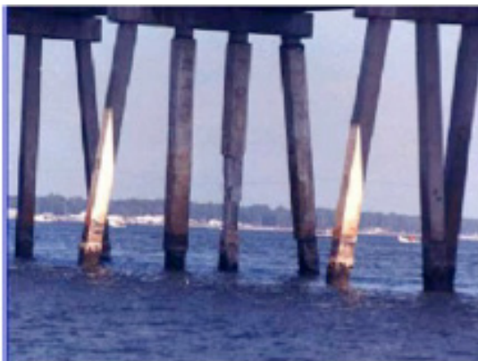
Rys. 24: Korozja zbrojonych pali betonowych w strefie zmiennego zanurzenia. 29
