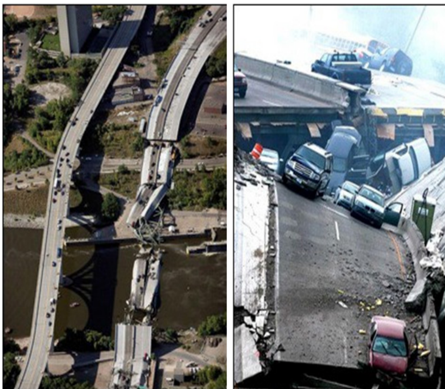
Rys. 26: Autostrada, katastrofa mostu 35W nad rzeką Mississippi w Minneapolis 1 sierpnia, 2007. 37,38
