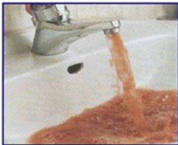
Rys. 5: Zanieczyszczenie medium z powodu korozji.
