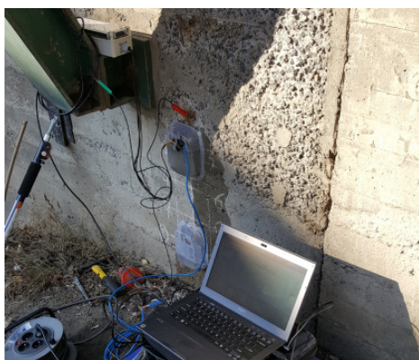
Wykonywanie pomiarów na obiekcie istniejącym
