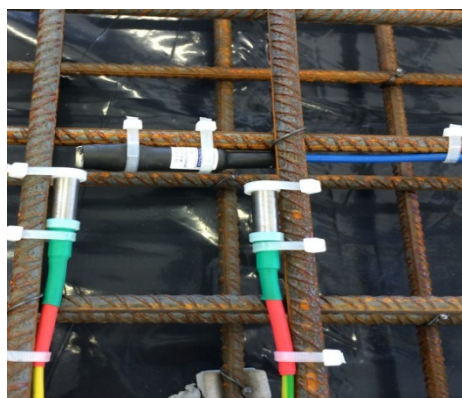
Instalacja elektrod pomiarowych na nowobudowanym obiekcie
